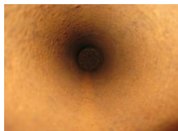
作業前軸内部状況①
