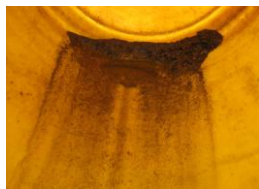
水洗浄排出痕①
