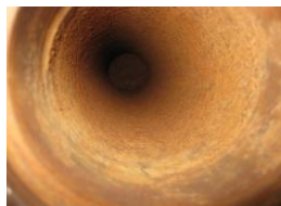
作業前軸内部状況②
